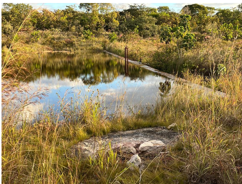
Figura 12. Barragem de derivação da Saneago, no córrego Riachão.
