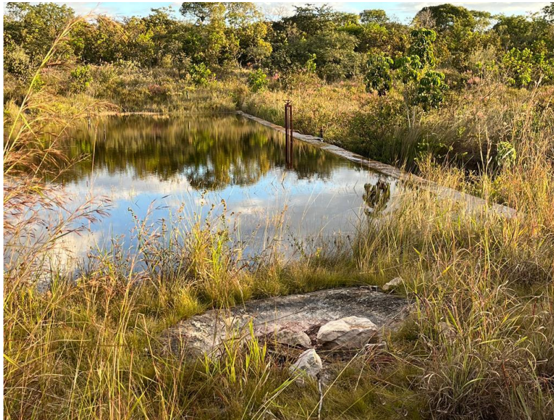
Figura 12. Barragem de derivação da Saneago, no córrego Riachão.
